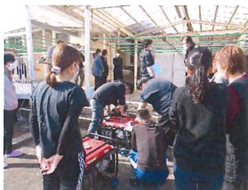
発電機作動確認
